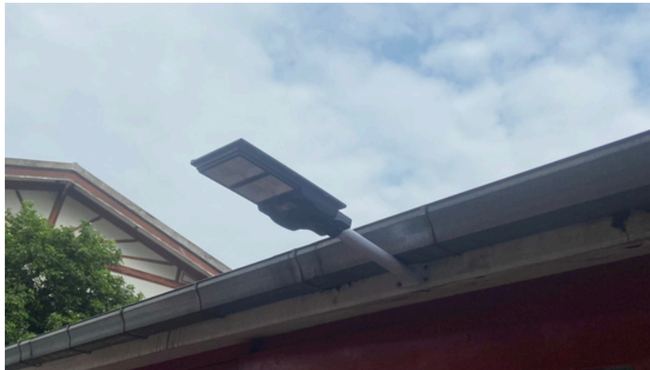
ติดตั้งไฟโซล่าเซลล์
