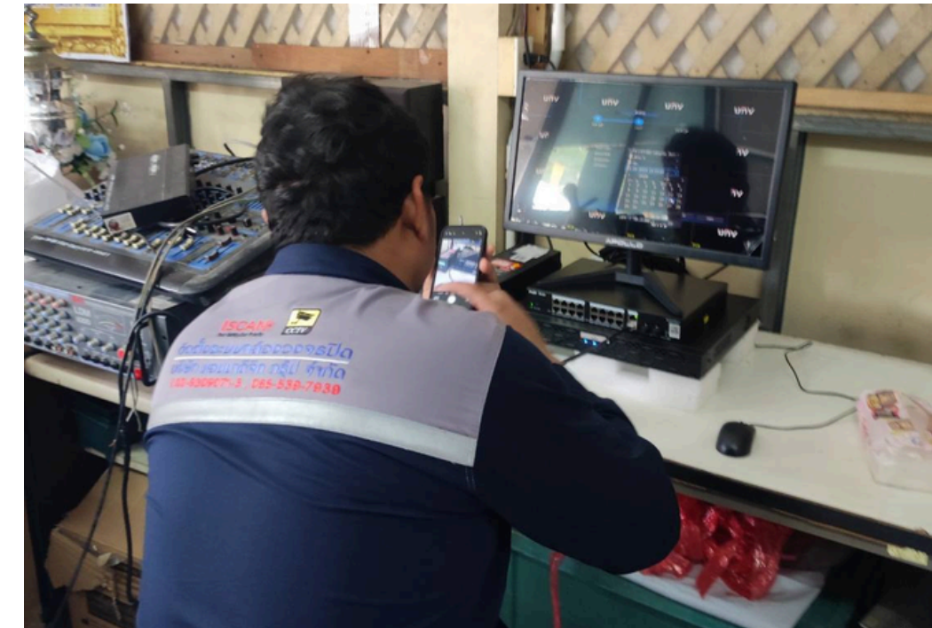
ติดตั้งกล้องวงจรปิด CCTV
